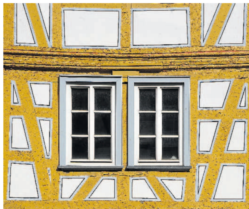
Urfarm des Fertigbaus: Fachwerkhäuser lassen sich gut versetzen.
